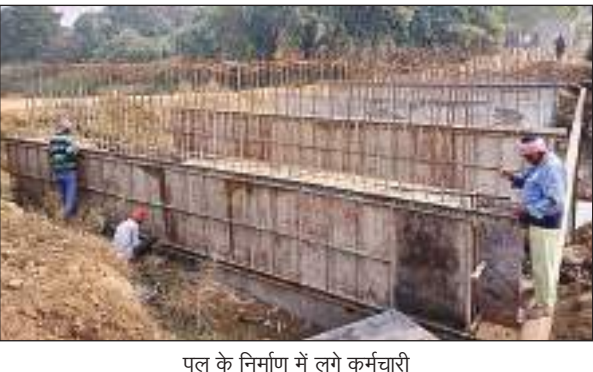
पुल के निर्माण में लगे कर्मचारी
