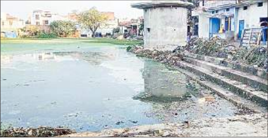
नगर पंचायत कार्यालय के सामने पोखरे में चल रहा सफाई कार्य।
