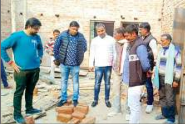
पंचायत भवन निर्माण कार्य का निरीक्षण करते हुए
