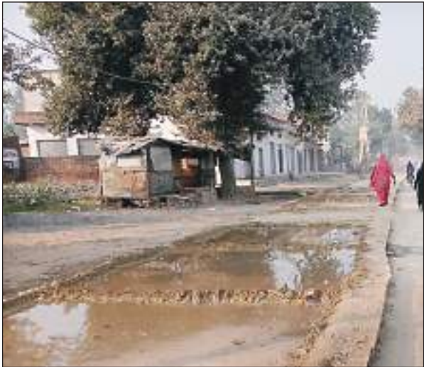
मानक की अनदेखी कर हो रहा सीमेंटेड रोड का निर्माण कार्य
