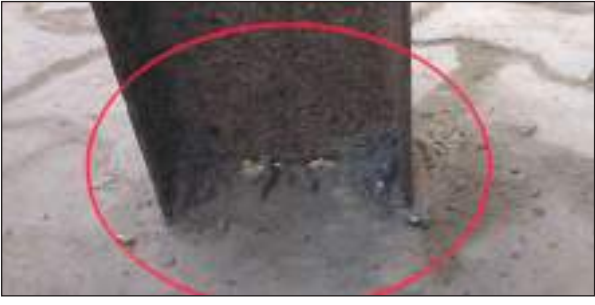
मोहल्ला पश्चिम तरफ में नीचे से जर्जर हो चुका विद्युत पोल
