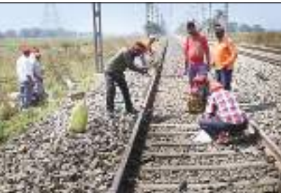
बारा कला हाल्ट-गहमर स्टेशन के बीच टूटी रेल पटरी को बदलते कर्मचारी।
