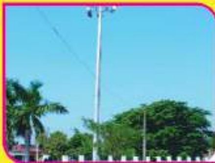
इब्राहिमपट्टी के जननायक चन्द्रशेखर हॉस्पिटल एण्ड कैसर इन्स्टीट्यूट में क्षेत्र पंचायत में लगा भव्य हाईमार्क टॉवर लाइट
