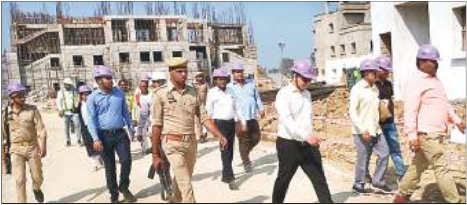
जिलाधिकारी ने निमार्णाधीन बाबा कीनाराम मेडिकल कॉलेज का किया निरीक्षण।
