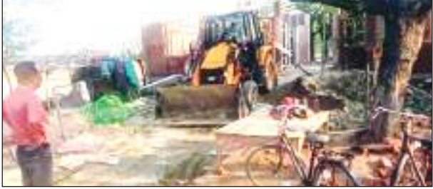
अवैध ढंग से हो रहे भवन निर्माण को ध्वस्त करता जेसीबी
