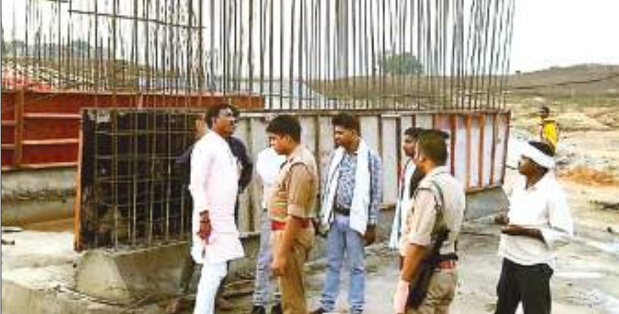
पुल निर्माण का निरीक्षण करते विधायक
