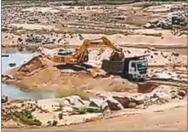
अमवार में स्पिलवे के नीचे से बालू खनन कर हाइवा में लोड करता पोकलेन
