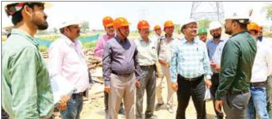
निर्माणाधीन मेडिकल कालेज का निरीक्षण करते डीएम सुजीत कुमार।
